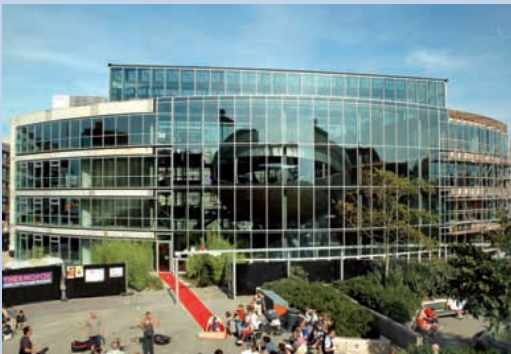
De indrukwekkende glasvlakte aan de achterzijde van het nieuwe gemeentehuis. Om te reinigen bereikbaar via een hoogtewerker.
