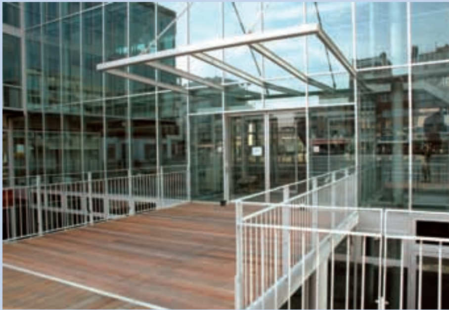
De hoofdingang van het nieuwe gemeentehuis is via een passerelle bereikbaar vanuit de Westendestraat of de Ropsweg. De hoofdingang wordt gekenmerkt door een glazen sas met luifel.
