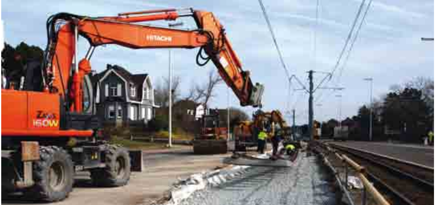
De Lijn vernieuwt vanaf 1 februari de tramsporen tussen Oostduinkerke en Nieuwpoort.
