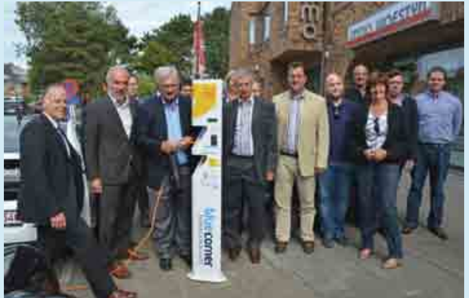
Elektriciteit tanken voor een elektrische wagen of fiets kan voortaan op het Guido Gezelleplein in Koksijde. Burgemeester Marc Vanden Bussche, gedeputeerde Guido Decorte en directieleden van Eandis demonstreerden hoe dat in z'n werk gaat.
