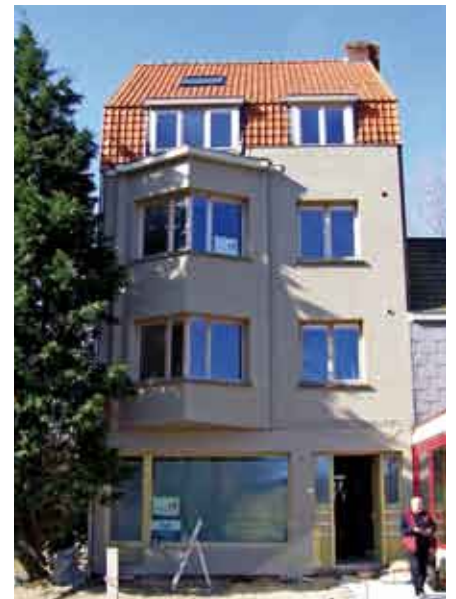
In dit huis heeft het RSVK vijf gerenoveerde sociale appartementen gerealiseerd.
