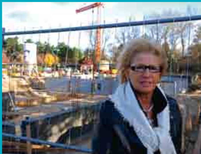
OCMW-voorzitter Greta Delie voor het nieuwe Sociaal Huis in aanbouw.
